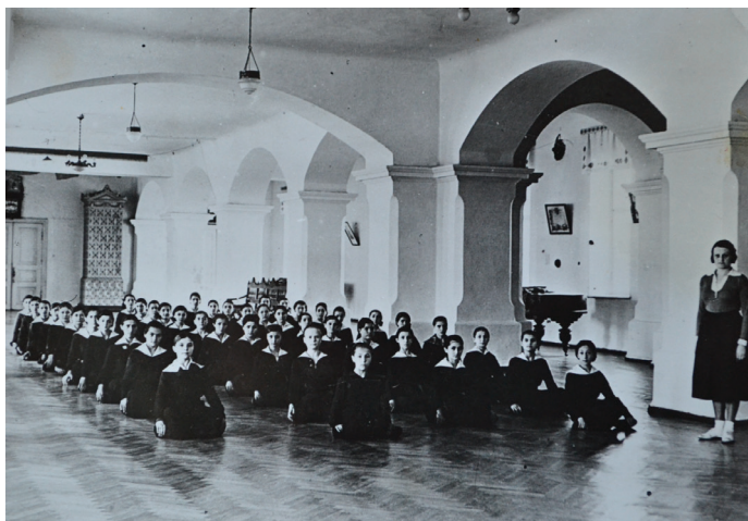
Sala de gimnastică a Liceului Eparhial de Fete din Chișinău, unde studia Marcela Mărgărit
